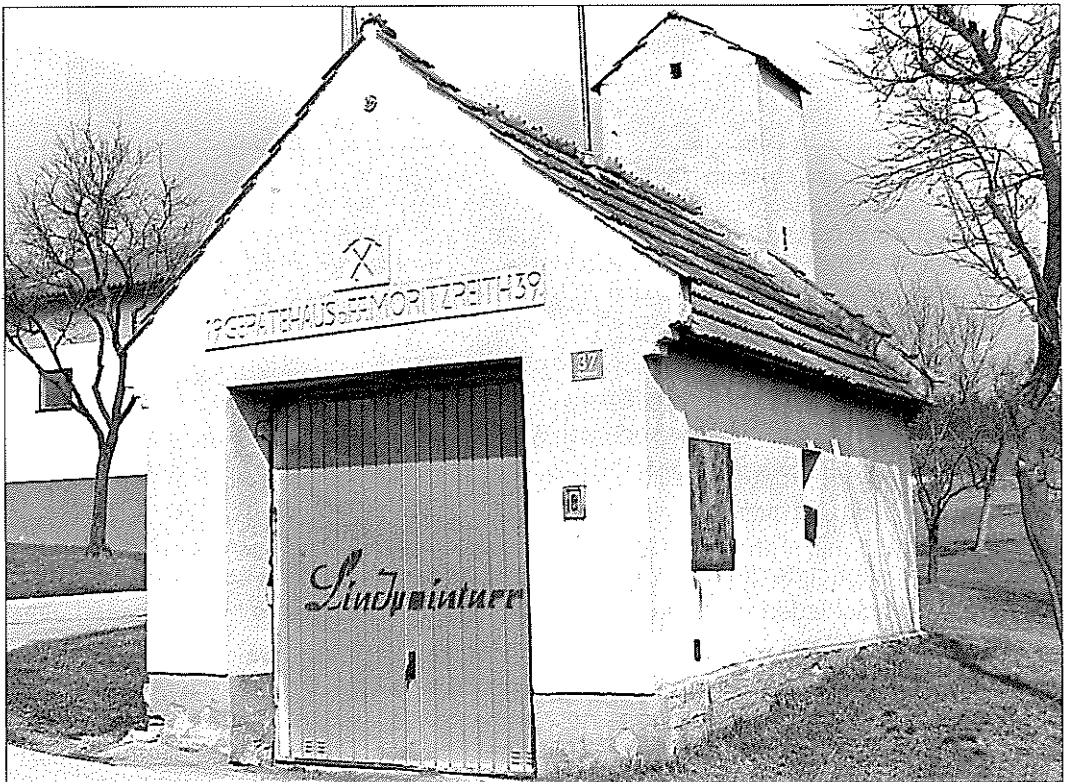
Feuerwehrhaus, errichtet im Jahre 1939, mittlerweile renoviert
